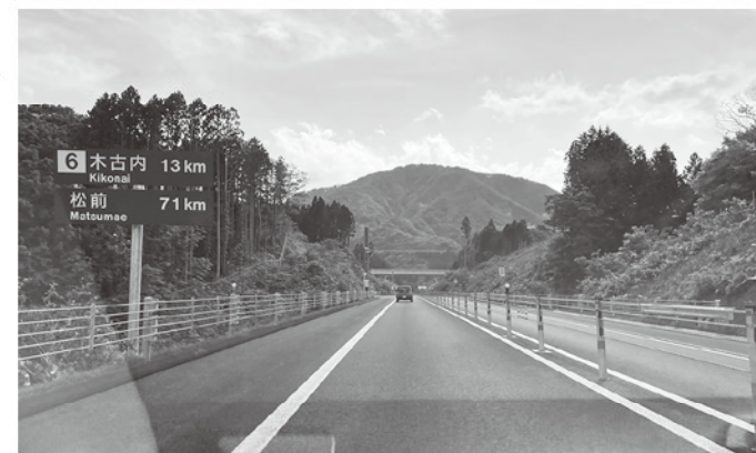
3月に開通となった函館江差自動車道
