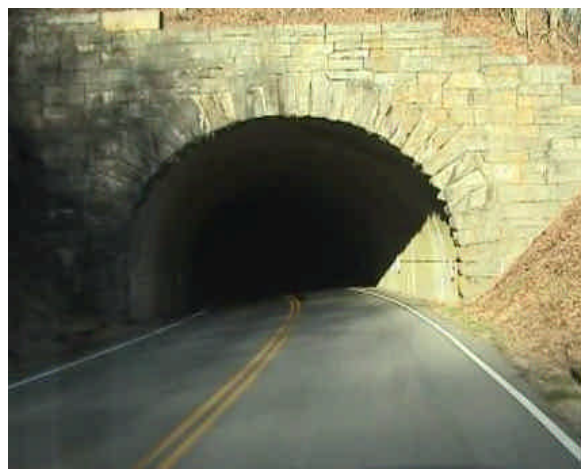
図表 2.1.11 周囲の景観になじんだトンネル坑口部分
