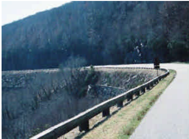
図表 2.1.2 天然石を利用した法面擁壁と木製の車止め
