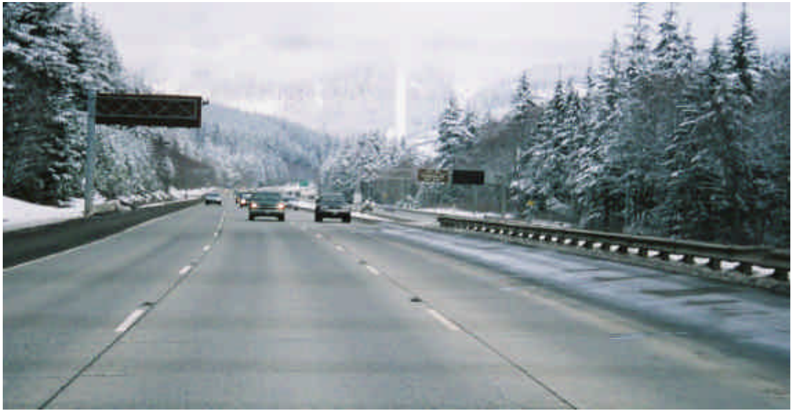
図表 2.2.14 I-90 は郊外部でも片側 3 車線
